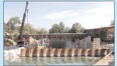
KW Raudaschl: Arbeiten im Schutz der alten Wehr
