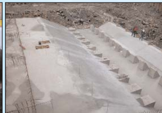
Krümmerschale für das KW Raudaschl (li); Öko-Bauleiterin Gotschy-Russ erläutert die ökologische Begleitplanung (Mitte); für das KW Lenzing wurde ein neuartiger Energievernichter entwickelt (re) Fotos: Brandstetter
