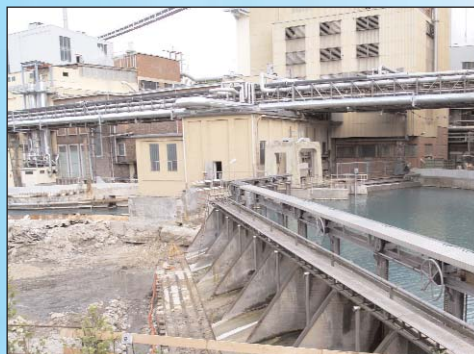
Auch das Kraftwerk am Gelände der Lenzing AG wird von der Fa. Brandstetter revitalisiert Foto: ZeK
