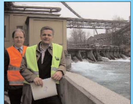
Josef Brandstetter (re) und Christian Reisinger (LAG) besichtigen die Baustelle Foto: LAG
