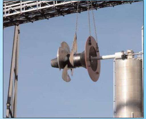
Das Einheben der tonnenschweren Laufräder ist Maßarbeit. (li u. re). Ein Techniker von GHE setzt ersten Probebetrieb in Gang (mitte) Fotos: Brandstetter
