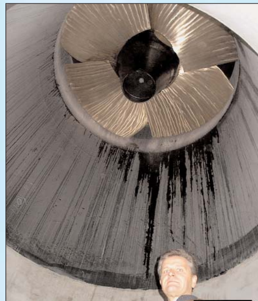
Eine seltene Perspektive: Betreiber Josef Brandstetter begutachtet die Turbine von unten. Foto: Brandstetter
