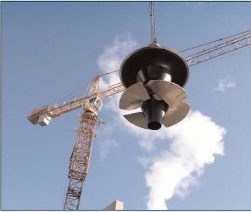
Das Einheben der tonnenschweren Laufräder ist Maßarbeit. (li u. re). Ein Techniker von GHE setzt ersten Probebetrieb in Gang (mitte) Fotos: Brandstetter
